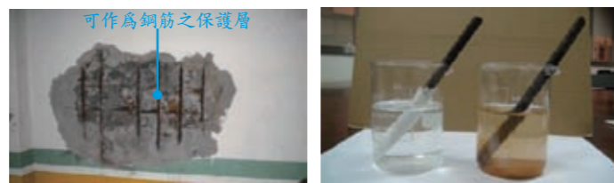
可作為鋼筋之保護層 修補已破損之裸露鋼筋混凝土牆面 建築遊艇防水材 W1 抗酸鹼實驗
